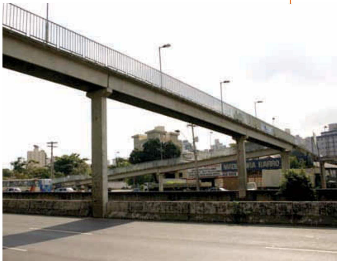
Passarela na Via Expressa Belo Horizonte | MG
