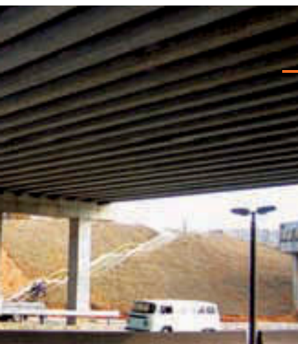
Viaduto na BR 381 Betim | MG
